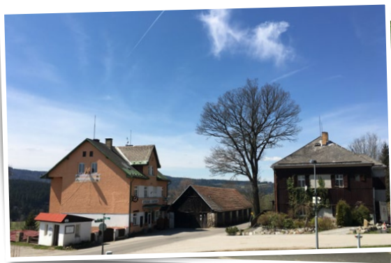
Okolí domu s otchodem
